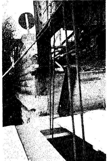
Appui sur console d'about (Pont de Bézigon) On distingue la béquille provisoire découpée
