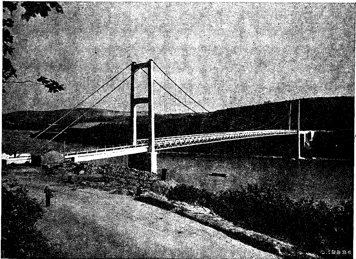
Pont suspendu rigide de Térenez (Finistère) sur l'Aulne Longueur de la travée centrale : 272 mètres
