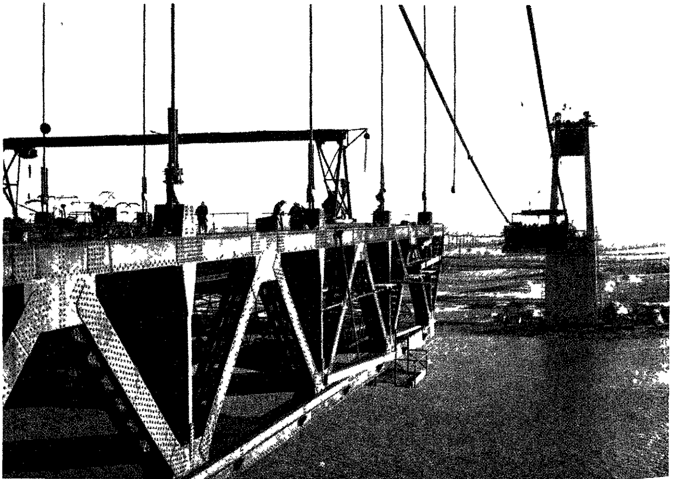
La charpente du tablier en travée centrale rive droite Dans le fond le nœud central et le pylône rive gauche
