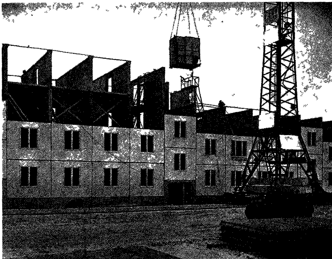
Un chantier d'immeubles prefabriques
