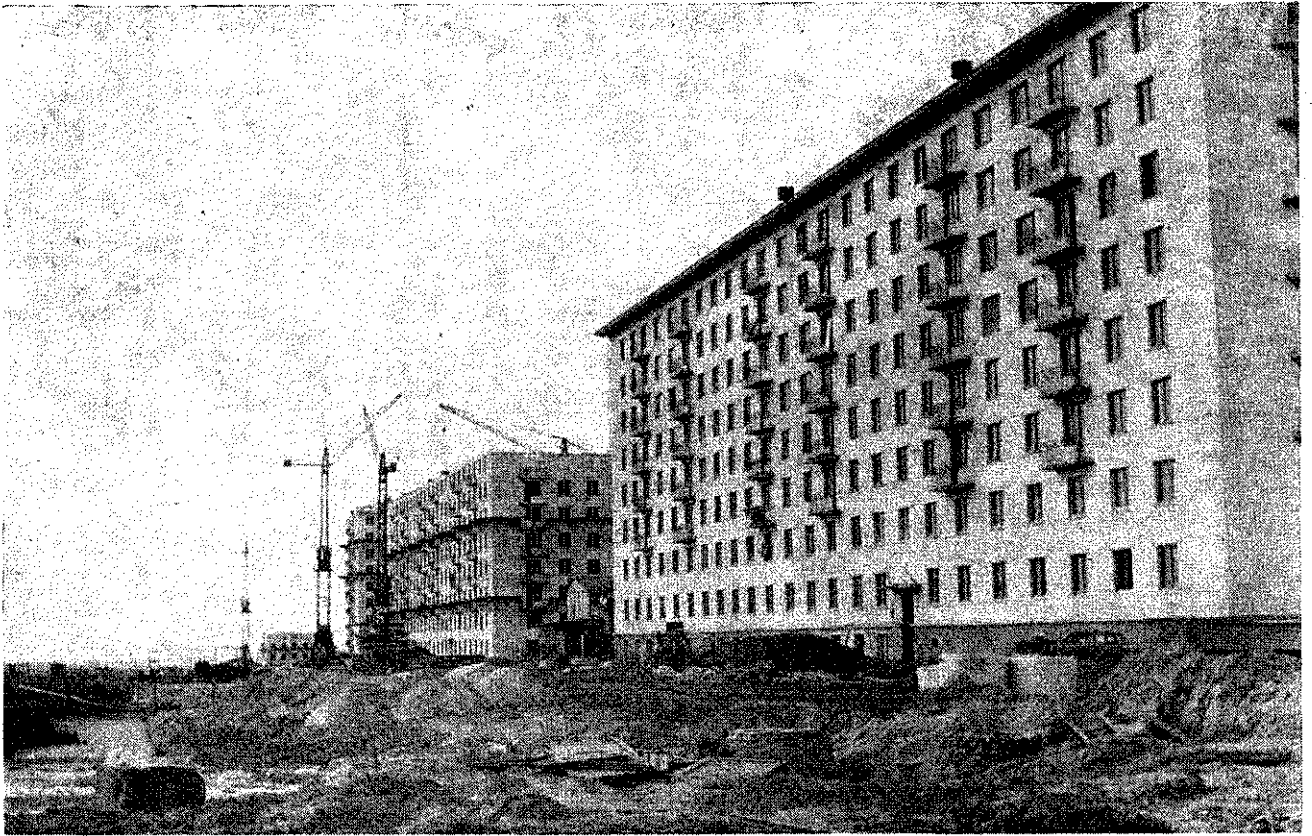
Logements occupés avant exécution de la voirie
