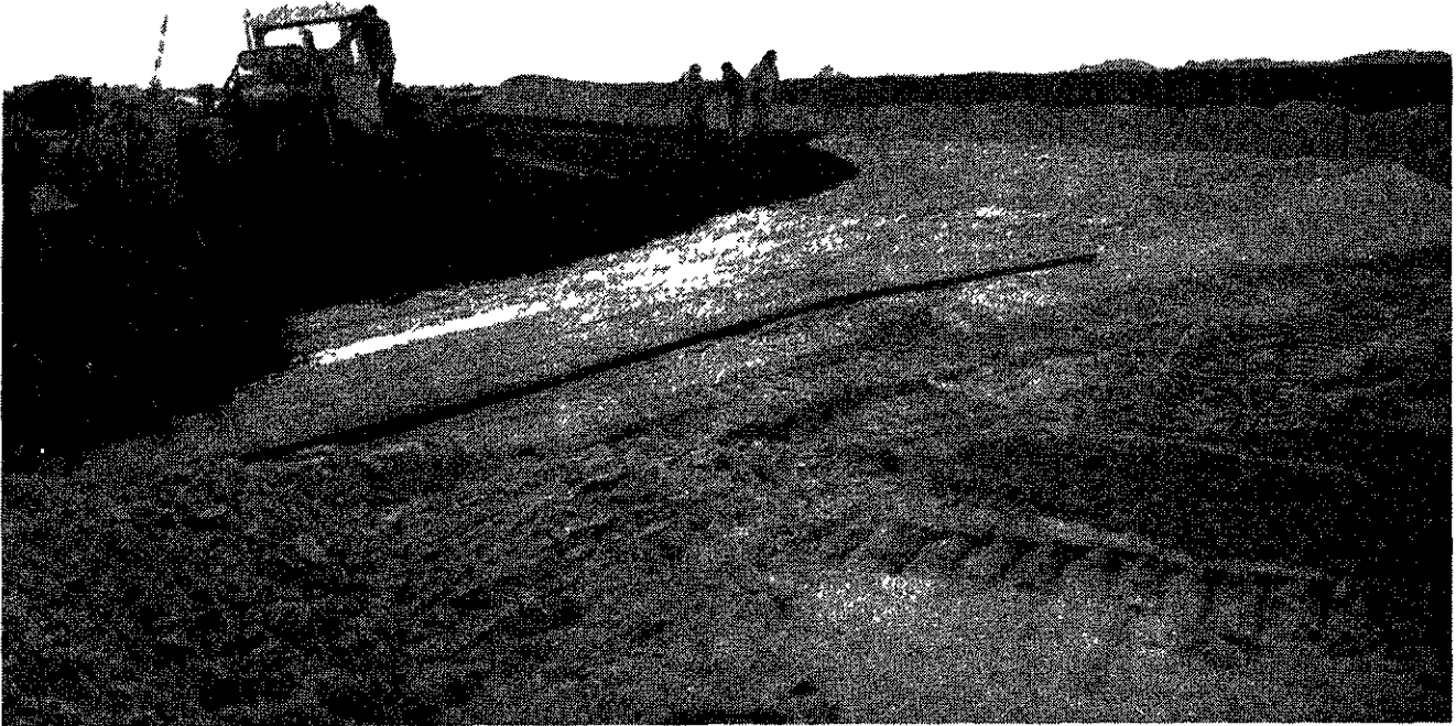
BASSIN MARITIME. — Mise en place du Béton bitumineux au Turnadozer
