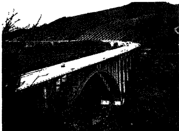
Ouvrage sur l'Autoroute du Soleil
