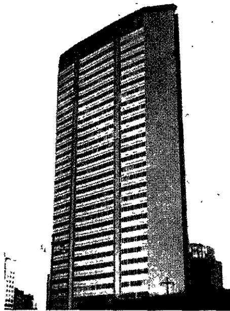
MILAN : Immeuble Pirelli
