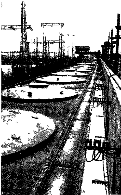
L'usine out-door de Krementchoug. On distingue le portique de 500 t qui se déplace sur le barrage. (Photo Bourquin)
